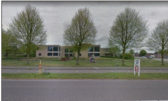
Zicht op het projectgebied vanaf de Spoorweg.
