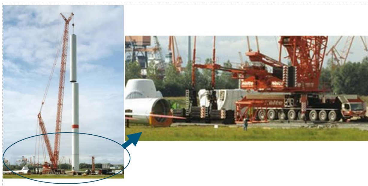
Figuur 24 Inhijzen mast van windturbine met kraan met superlift
