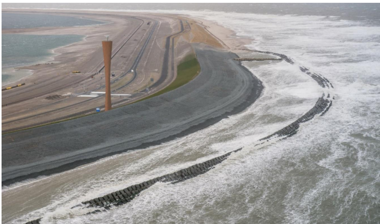
Figuur 21. Harde zeewering met blokkendam en radartoren en de overgang naar de zachte zeewering
