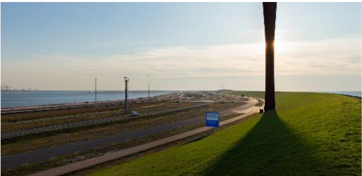
Figuur 4. Foto huidige situatie vanaf de radartoren op de harde zeewering (kijkrichting zuidoosten) [bron: Pondera Consult]
