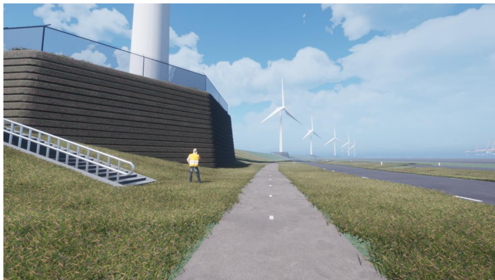
Figuur 4.10 Beeld van fundament windturbines harde zeewering (bron: RHDHV)
