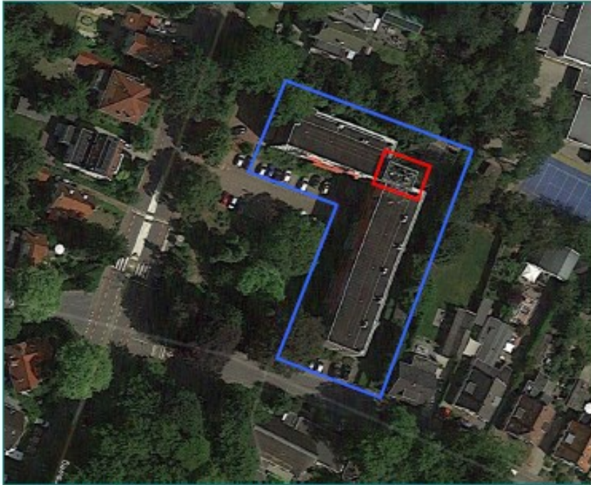
Figuur 1: Plangebied met te renoveren complex - blauwe kader. Het rode kader betreft het te renoveren ketelhuis.
