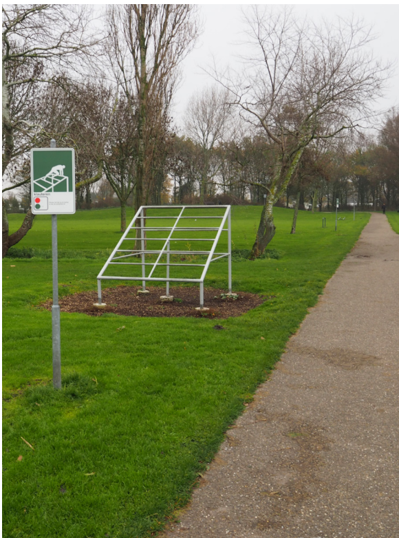
het fitnessparcours kent achterstallig onderhoud
