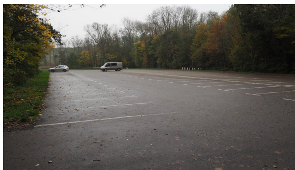
asfaltparkeerplaatsen heten je 'welkom'
