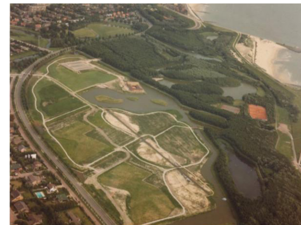
het Westduinpark tijdens aanleg
