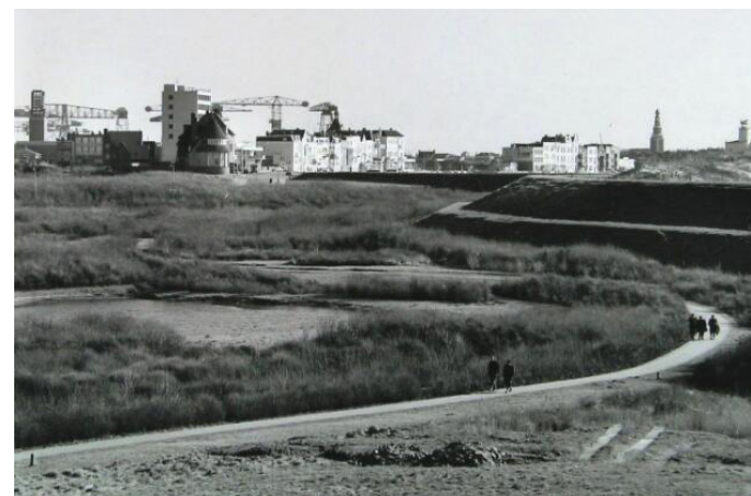
het Nollebos tijdens de aanleg
