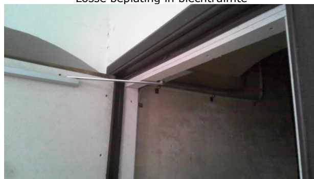
Beplating tegen deurkozijn
