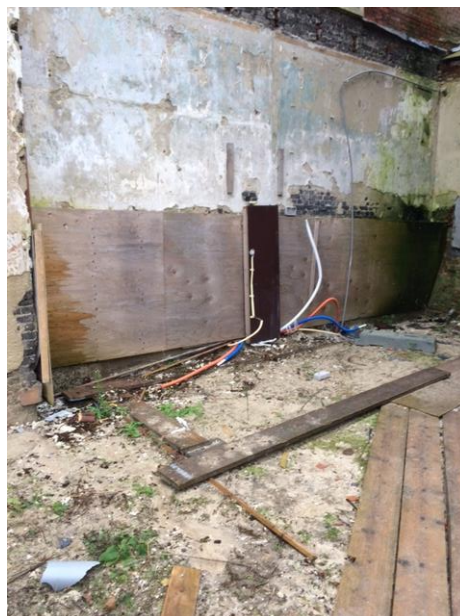
De asbestplaten zijn afgeschermd met houtplaten
