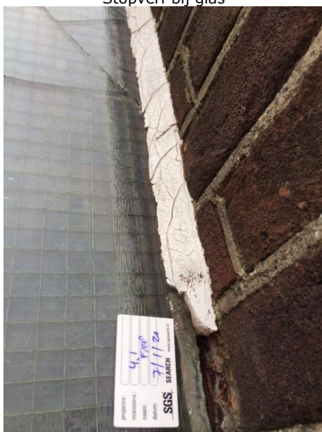
Stopverf naast glas/kozijn
