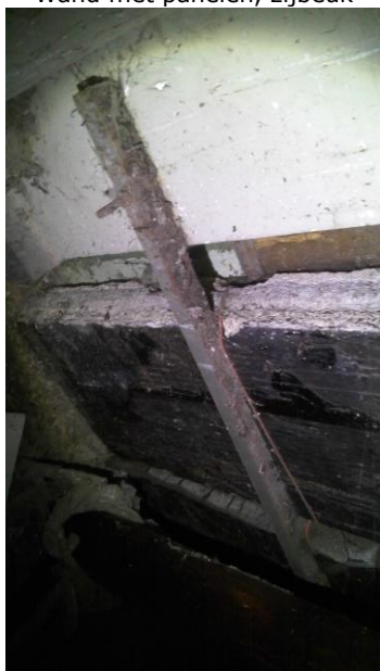
Bevestiging van de wandpanelen, provisorisch uitgevoerd
