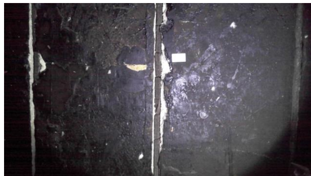
Paneelelementen, voorzien van een dakleer/bitumenlaag aan beide zijden
