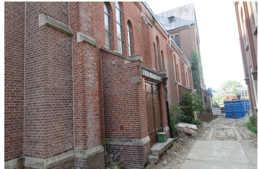
Afbeelding 9. De rechter zijbeuk met direct in de eerste travee de in 1931 aangebrachte toegang, in de derde travee achter de struik de uitgebouwde biechtstoel.
