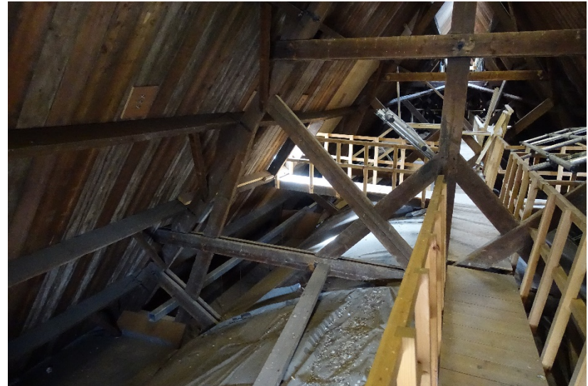
Afbeelding 6. De kapconstructie gezien naar de viering. De spanten dragen op muurplaat en de collonetten. Het tongewelf bestaat uit schenkels die dragen op een balk bij de aanzet.
