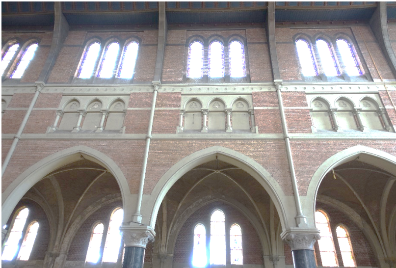
Afbeelding 12. Rechterzijde van het schip met de bovenzijde van de zuilen met kapitelen, de scheibogen, het schijntriforium en de lichtbeuk. Het geheel is oorspronkelijk.
