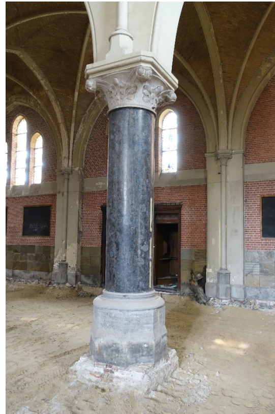
Afbeelding 17. De tweede zuil aan de rechterzijde. Het achzijdige hardstenen basement staat op een gemetselde fundatie. De zuil is met marmerstuc gepolijst. Het kapiteel is een monolitisch kalkstenen blok. Achter de zuil de biechtstoel in de zijbeuk.
