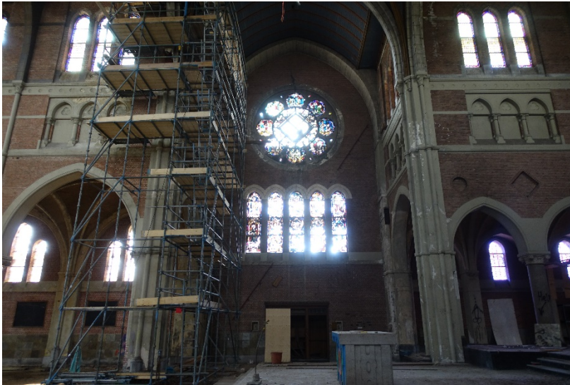
Afbeelding 14. De linkerzijde van het dwarsschip. In het midden van de viering het in 1966 geplaatste altaar.
