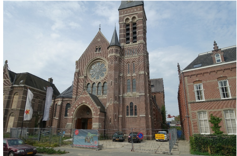
Afbeelding 7. De voorgevel van de kerk met van links naar rechts de doopkapel, het uitgebouwde portaal, de traptoren en de toren. Links van de kerk de pastorie.
