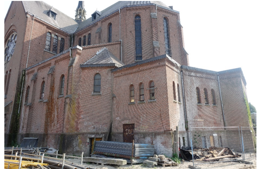
Afbeelding 5. De noordelijke zijde van het koor met de kapel en sacristie met nevenruimtes. De hoofdingang naar de kelder bevindt zich links van de stapel bouwhekken.
