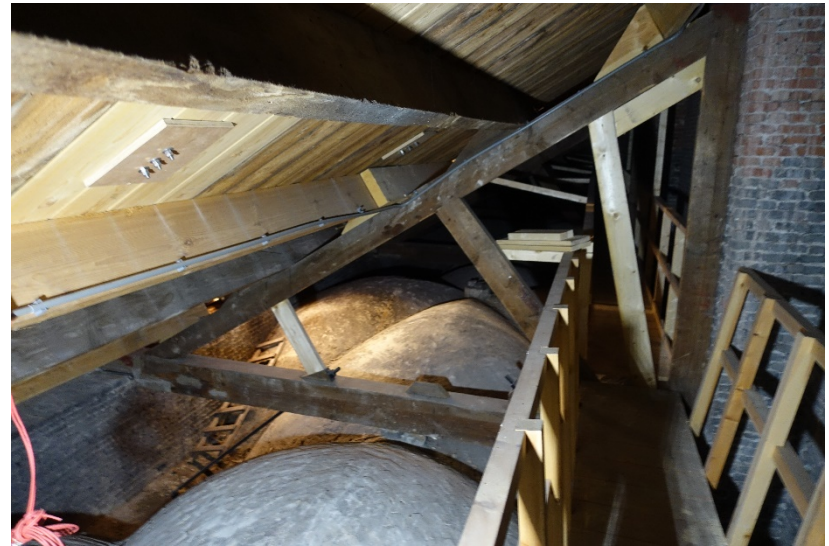
Afbeelding 21. De kapconstructie onder het lessenaarsdak van de linker zijbeuk. De halve spanten zijn van twee extra schoren voorzien en er zijn drie gordingen bijgeplaatst.
