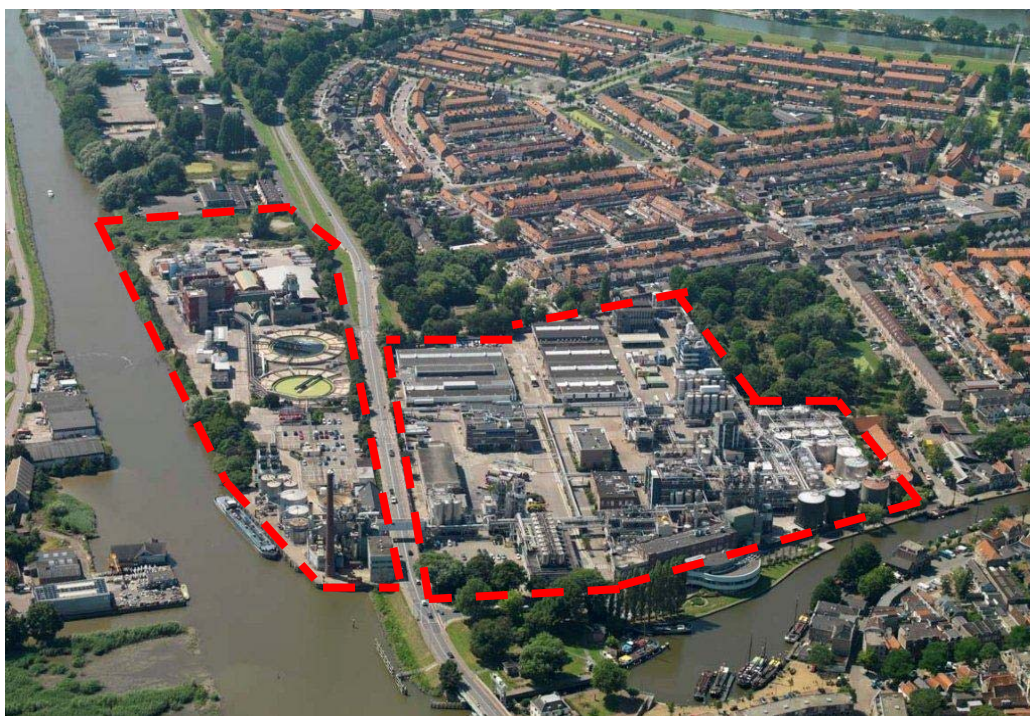
Figuur 1-1: Luchtfoto terrein Croda (2014). In rood de inrichtingsgrenzen.
