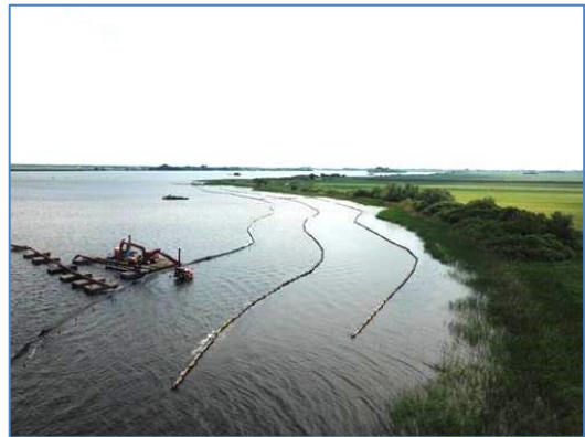
Figuur 1 Aanleg ondiepe zone in De Kûfurd
