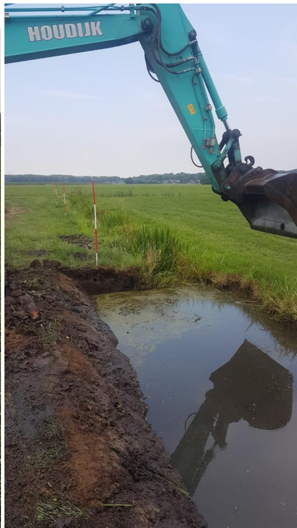
2c: Compensatie d.m.v. verbreden watergang met gemiddeld 50cm. (=72m x 1m = 72m 2 )
