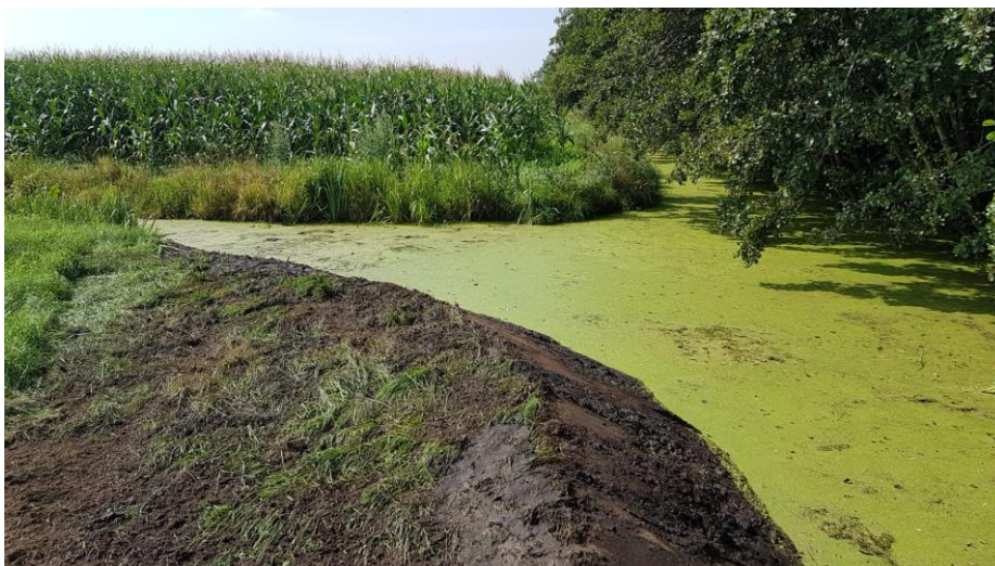
2b: Compensatie d.m.v. verbreden watergang met gemiddeld 50cm.(=74m x 1m = 74m)
