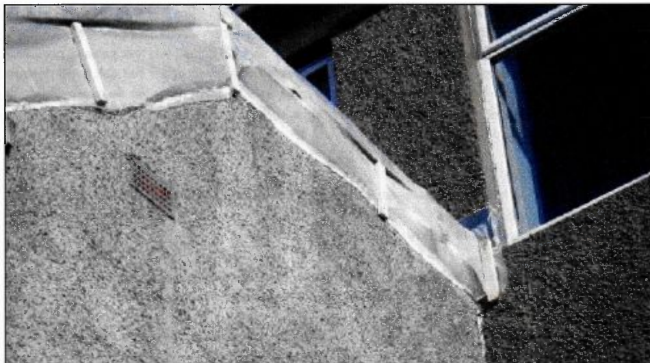
Figuur 7: plastic exclusion flaps vastgezet met waterbestendige lijm en houten latjes, bruikbaar voor grotere openingen.
