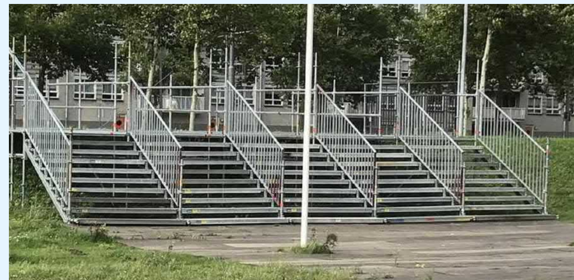
figuur 8179: voorbeeld tijdelijke trappen
