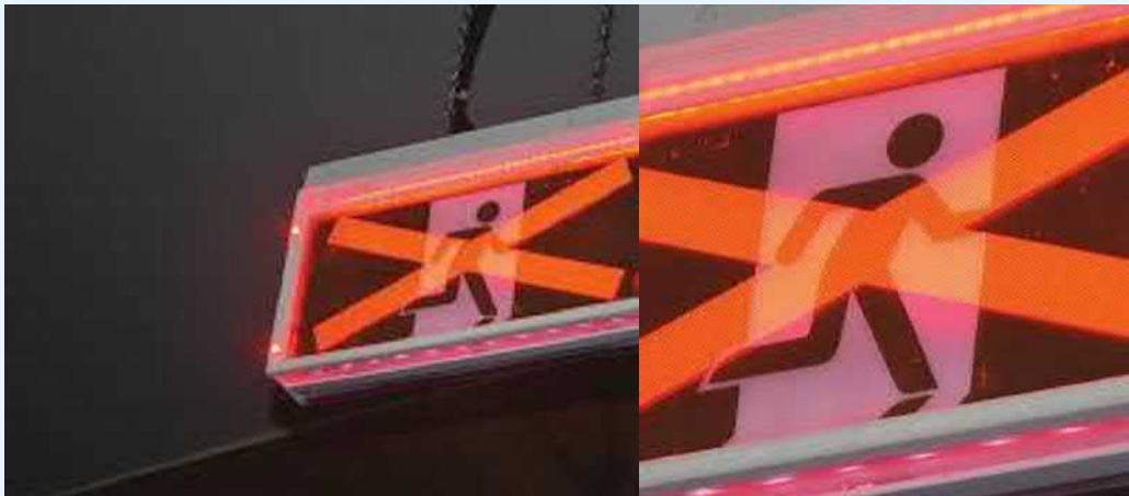
figuur 4745: voorbeeld dynamische vluchtrouteaanduiding met een rood kruis: geen toegang
