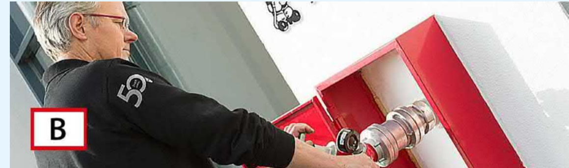
figuur 5654: aansluitpunten in een kast
