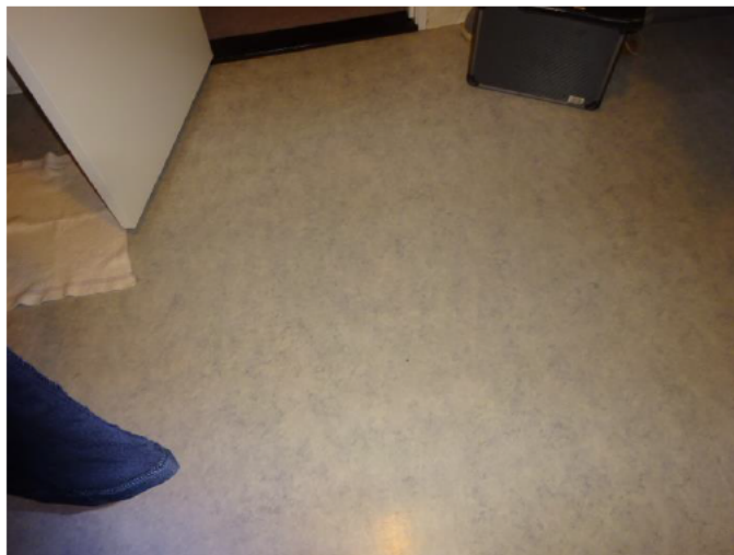
Vloerafwerkingen niet asbestverdacht
