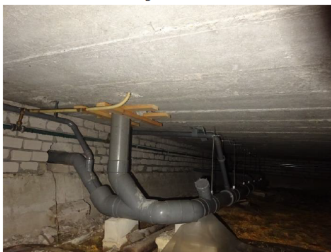
Overzicht kruipruimte met PVC riolering
