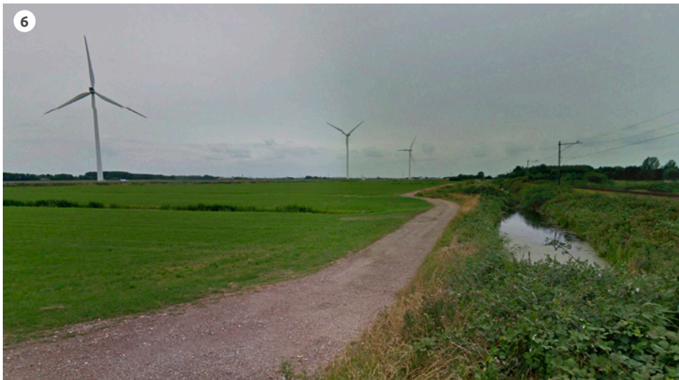
6 Onderhoudspad RWS ten noorden van plangebied, rechts het spoor, links de windmolens (Bron Google Streetview)
