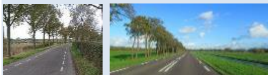
Buiten de bebouwde kom: links een erftoegangsweg (60 km/u) en rechts een gebiedsontsluitingsweg (80 km/u)
