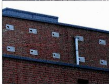
IB GZ 01 kasten ingemetseld in de gevel
