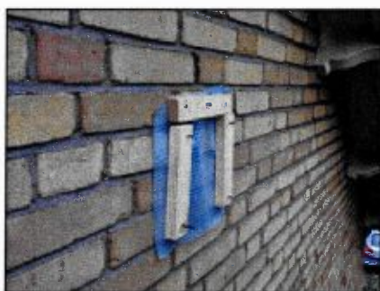
Twee modellen van een exclusion flap, waardoor de vleermuis nog wel naar buiten kan, maar niet meer terug naar binnen.
