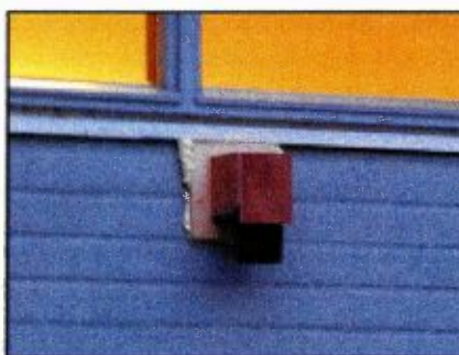
Twee modellen van een exclusion flap, waardoor de vleermuis nog wel naar buiten kan, maar niet meer terug naar binnen.
