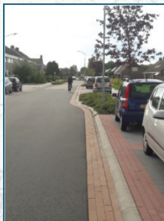
Voorbeeld reconstructie: W.A. Scholtenweg Zuidbroek.
