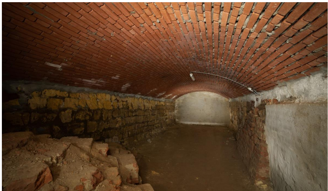
Figuur 6. De nieuwste vleermuiskelder (nummer 9), welke in 2009 werd ontgraven en ingericht als overwinteringsplek voor vleermuizen. Het betreft de grootste kelder (foto: Paul van Hoof).
