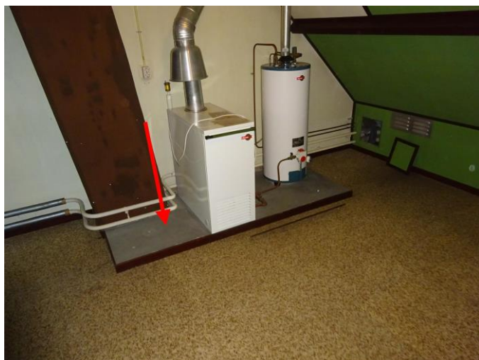
Foto 11 | Golfplaat onder beton
