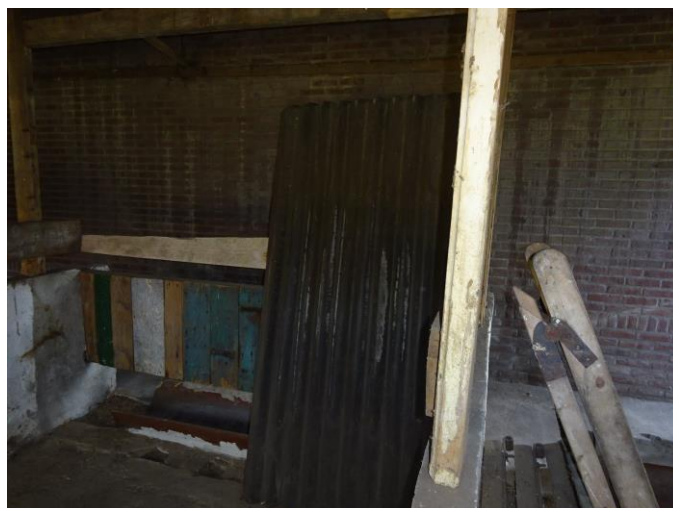
Bitumen golfplaten niet asbestverdacht
