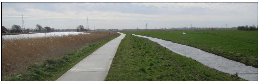
Afbeelding 10 Impressie plangebied. Teen sloot en binnentalud.
