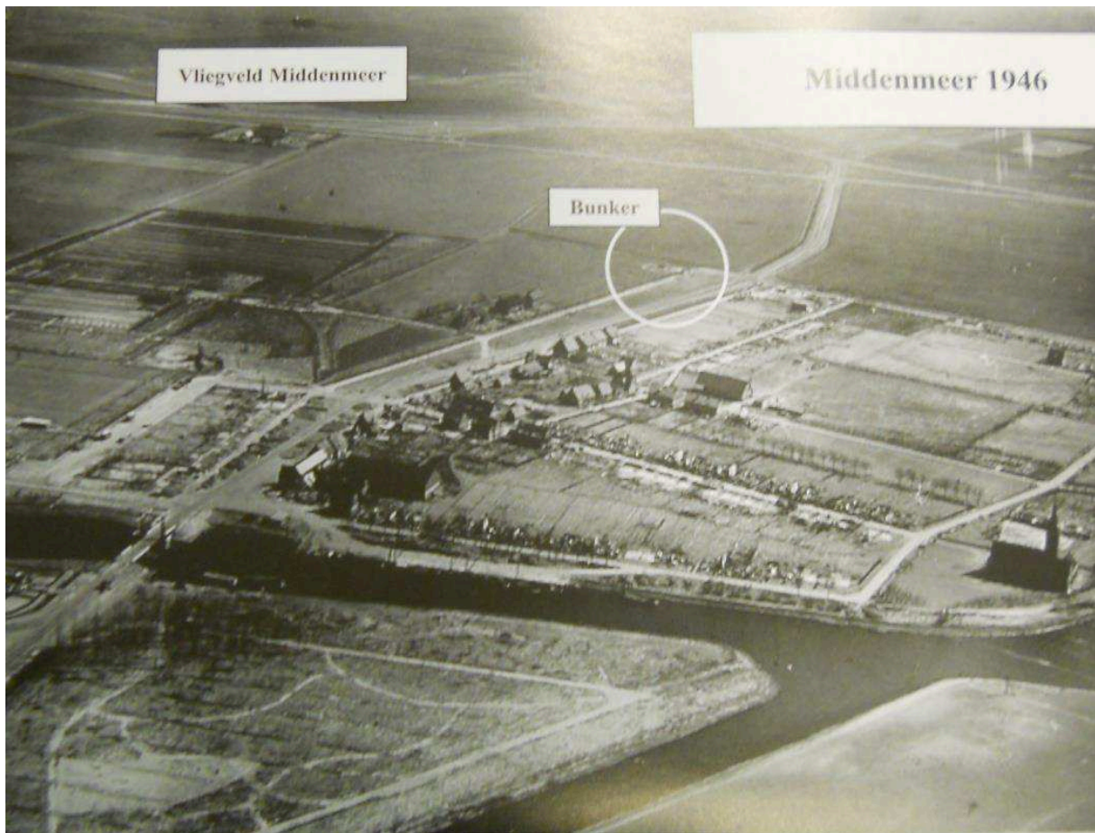
Figuur 10: Op deze luchtfoto uit 1946 van Middenmeer is goed te zien hoe weinig van de oorspronkelijke bebouwing bewaard is gebleven na de inundatie. In de rechterhoek is de Nederlands-Hervormde Kerk te zien die binnen het onderzoeksgebied valt. De overige bebouwing langs de Wieringerwerfvaart had dusdanig veel schade geleden dat de lokale overheid, nadat de polder in december 1945 weer was drooggevalen, deze liet slopen. Bron: 1940-1945 de Wieringermeer.
