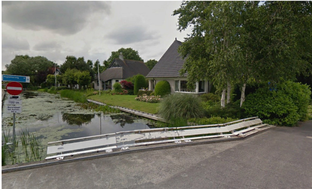
Fig. 3.4. Bebouwing Dr. van Noortstraat (achter projectlocatie)
