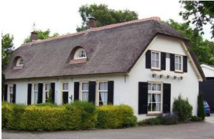
Wit gepleisterde gevel met rieten kap
