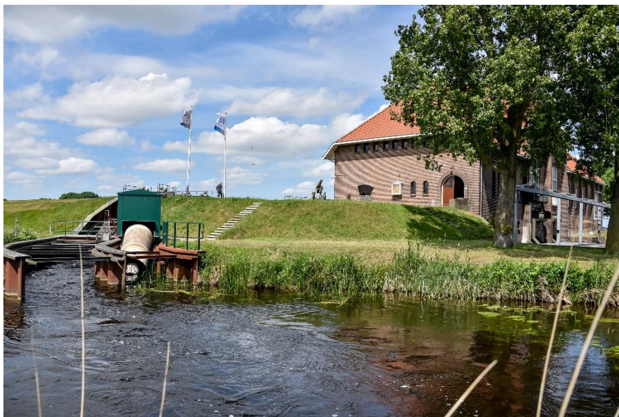
Waterinlaat bij gemaal Stroink
