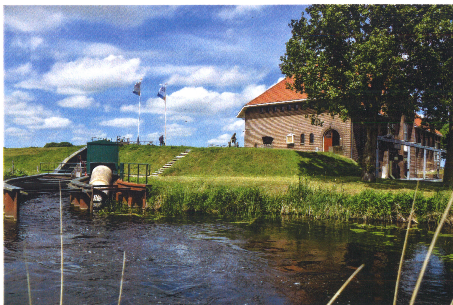
Waterinlaat bij gemaal Stroink
