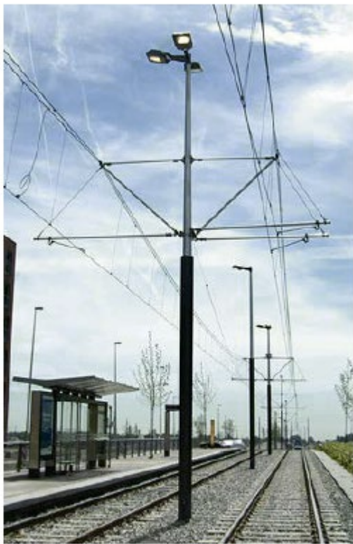
NPK-mast en -armatuur
