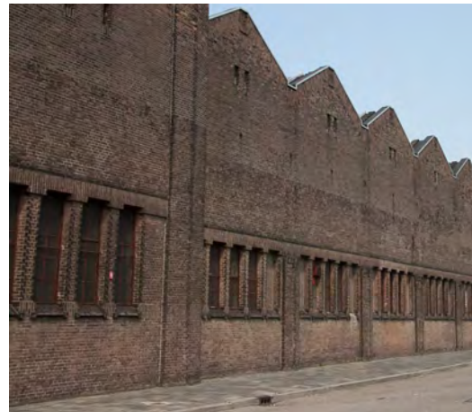
Plastiek in de gevel door gebruik baksteen
