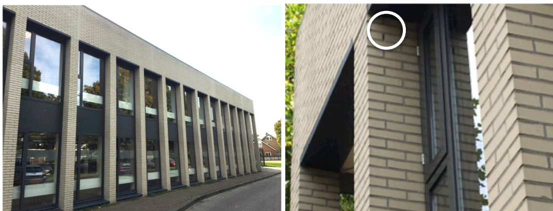
Foto 5,6 De noordkant van het Wijkservicecentrum, met aan de bovenzijde open voegen (cirkel rechts).
