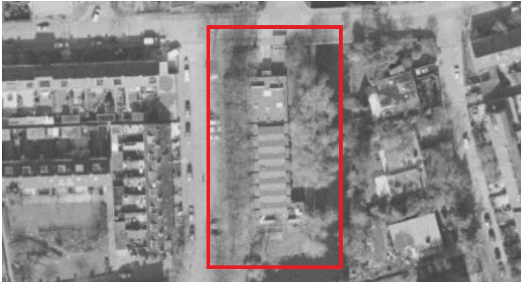
Afbeelding 4 Luchtfoto zwembad De Dolfijn (2006)
