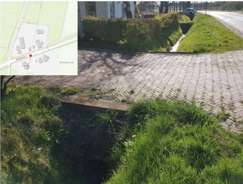
Foto 6: te verdiepen inliggende duiker.
