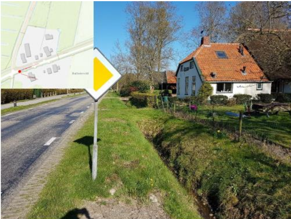
Foto 5: te verdiepen inliggende duiker.
