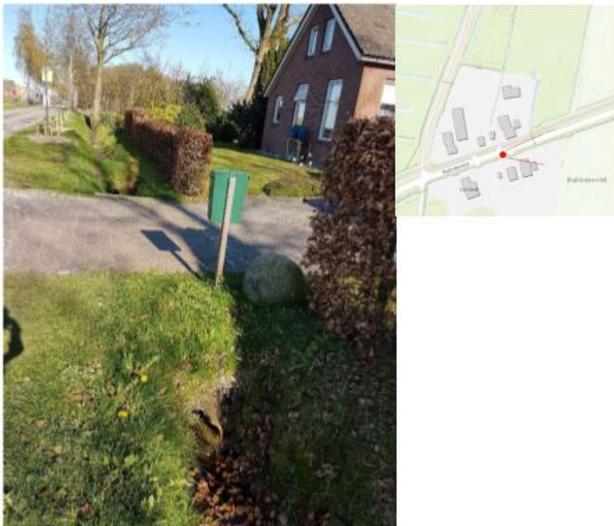
Foto 8: te verdiepen inliggende duiker.
