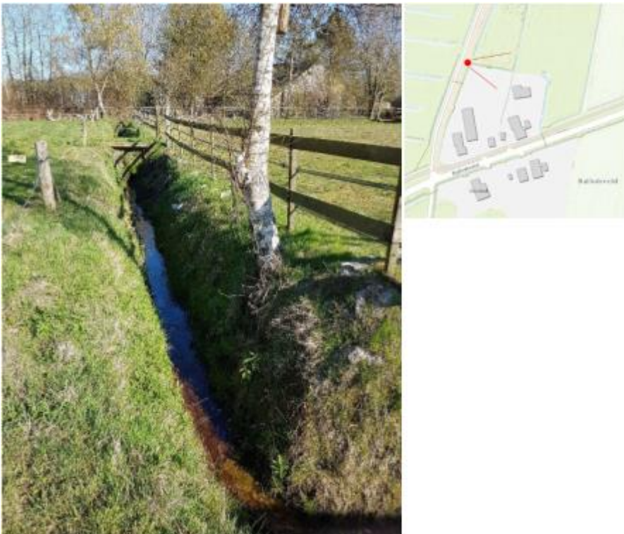
Foto 3: te verruimen inliggende duiker.
