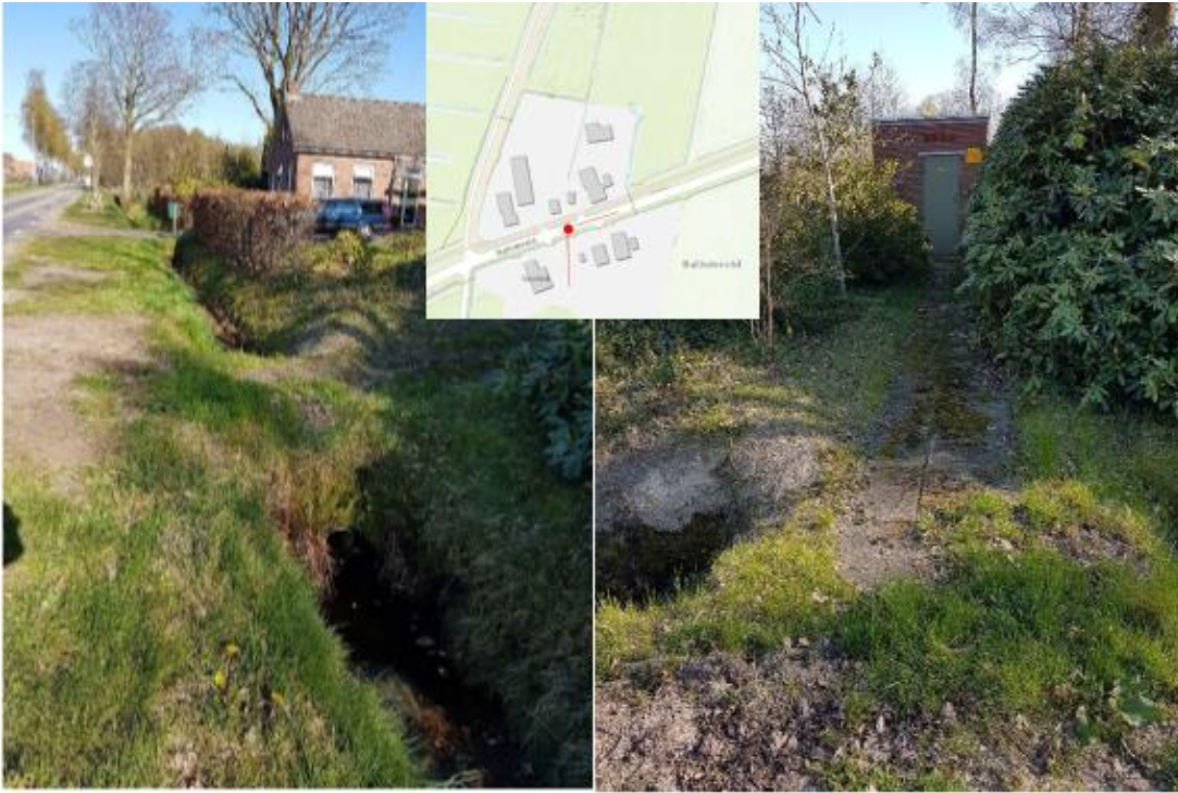
Foto 7: te verdiepen inliggende duiker.
