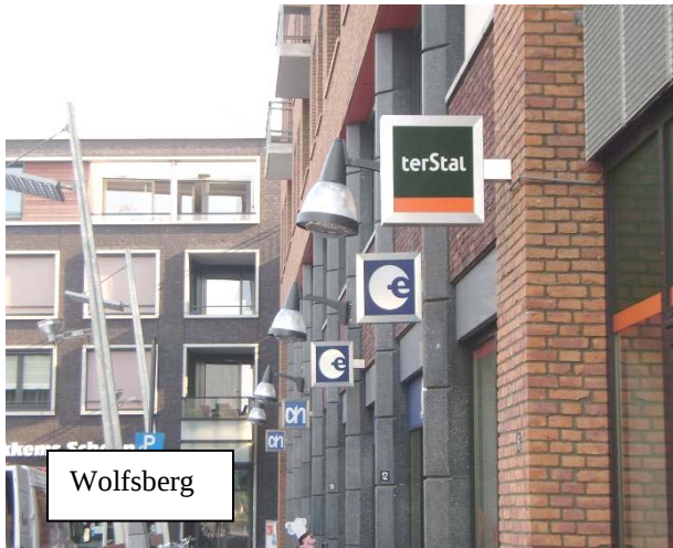
Uitvoering gevelbord haaks op de gevel.
