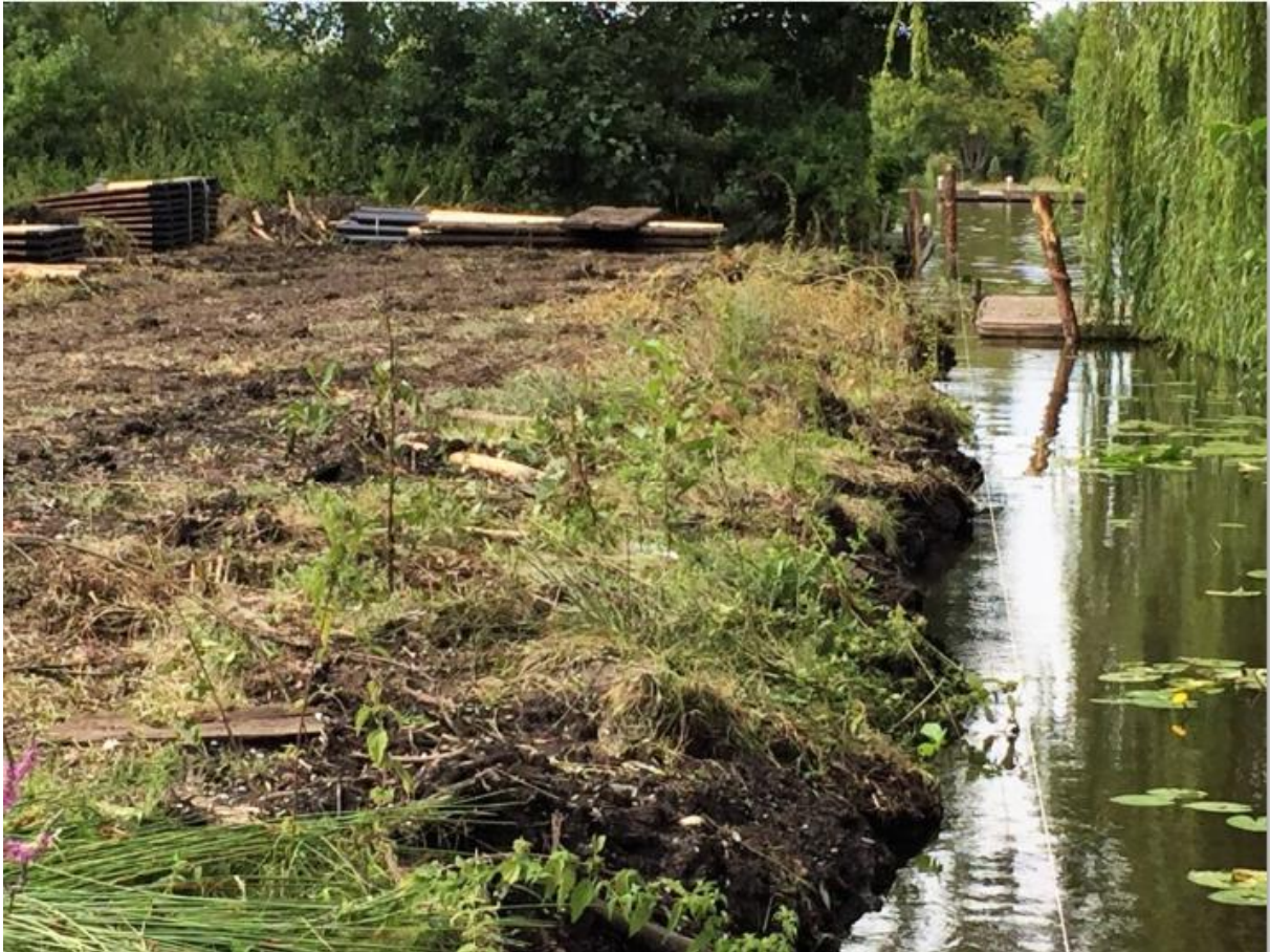
Noordoostzijde in de aanlegfase. Contouren aanleg lage beschoeiing zichtbaar.
