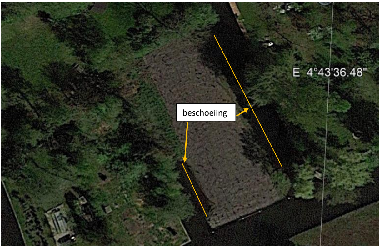
Overzicht perceel met lijn beschoeiing N/O zijde (45m) en Z/W zijde (15m) aangegeven.
