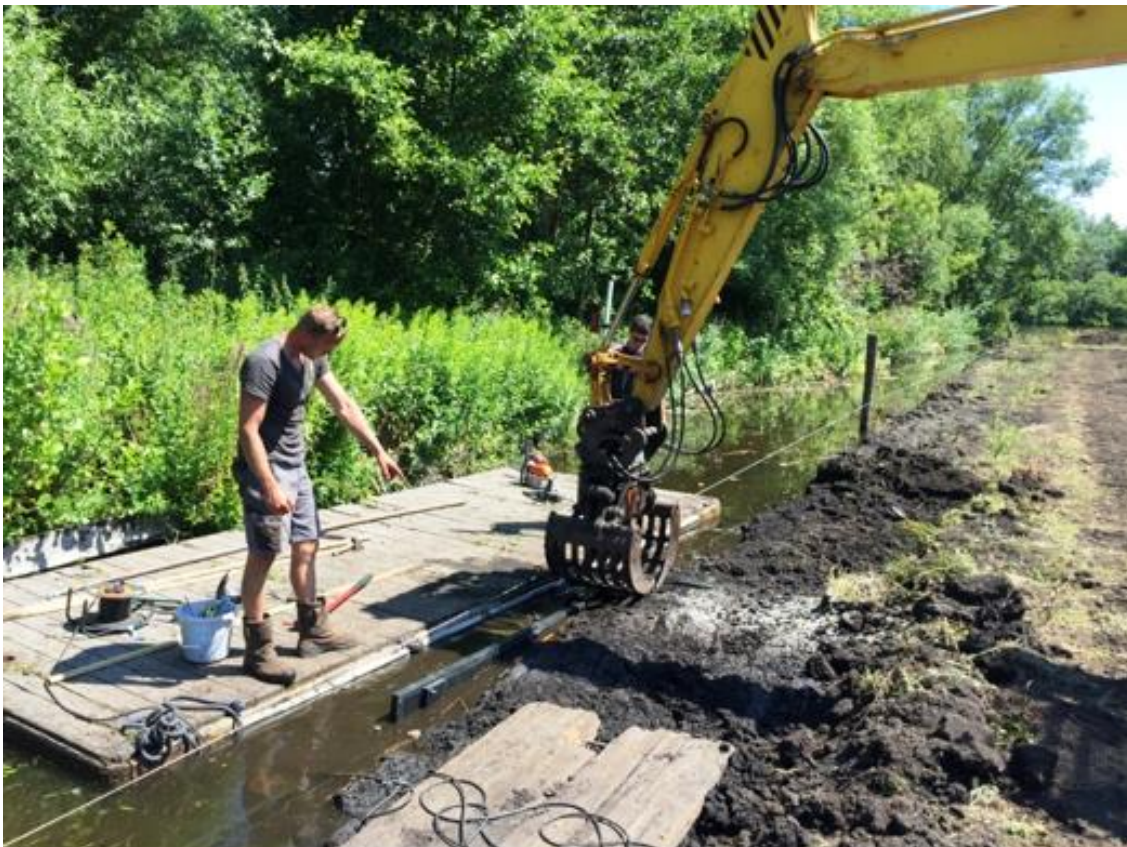
Aanleg lage beschoeiingen noordoostzijde perceel
