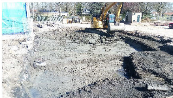
Foto 4: Situatieoverzicht sanering verontreiniging voor voormalige werkplaats/loods (bodem 21 en 22).
