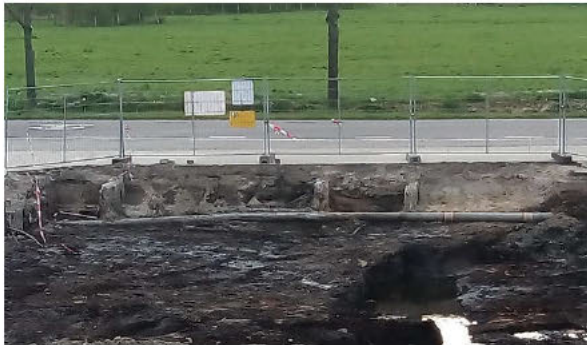
Foto 9: Eindsituatie wand 52 en wand 53 bij sanering bij inrit. Ter plaatse van wand 53 restverontreiniging achtergebleven, doordat verder sanering met kabels- en leidingen en het fietspad niet mogelijk was. Tevens tot erfgrens gegraven.
