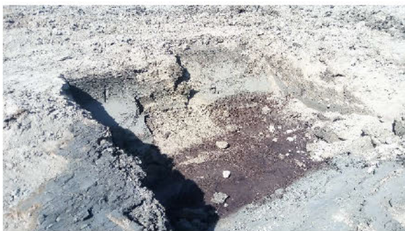
Foto 15: Eindsituatie sanering in pandige spot bodem 43.
