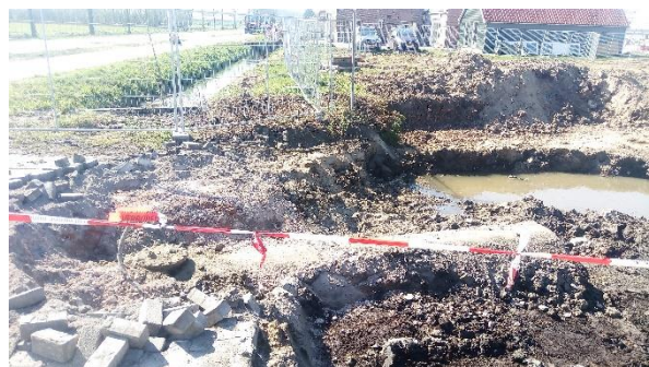
Foto 2: Ligging oostelijke tank.
