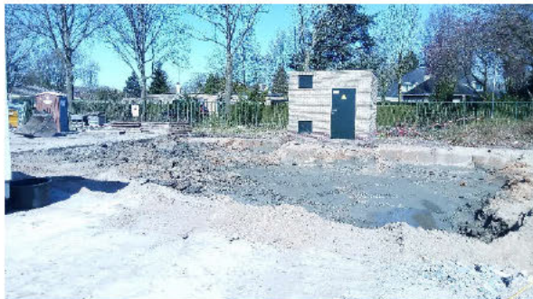
Foto 1: Resultaat sanering verontreiniging bij trafo (bodem 1 en 2)
