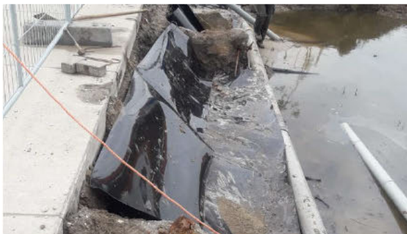
Foto 11: Bij einde van de saneringswerkzaamheden is de tijdelijke folie vervangen voor duurzame chemiebestendige folie en stevig vastgemaakt.)
