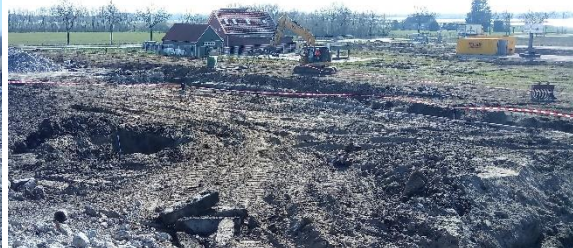
Foto 4: Locatie van inpandig onderzoek; gezien vanaf westelijke richting.
