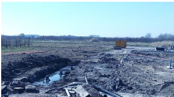
Foto 3: Locatie ter plaatse van bodem 13 (bovengrond reeds verwijderd en aangrenzend in depot gezet), bodem 11 en 12, wat lager gelegen i.v.m. verwijderde wasstraat en bodem 41 en 42 (meest rechts).
