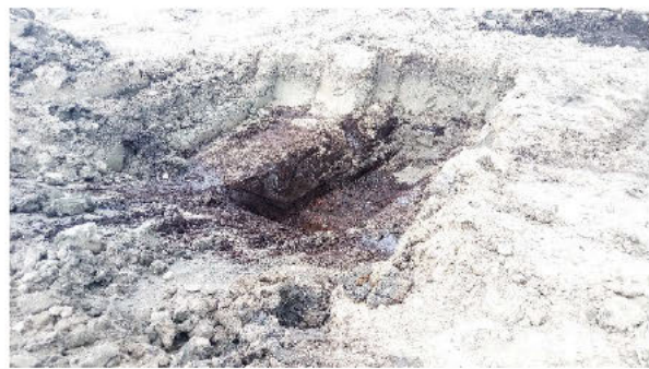
Foto 12: Eindsituatie sanering tankgat extra aangetroffen inpandig tankje (bodem 31).
