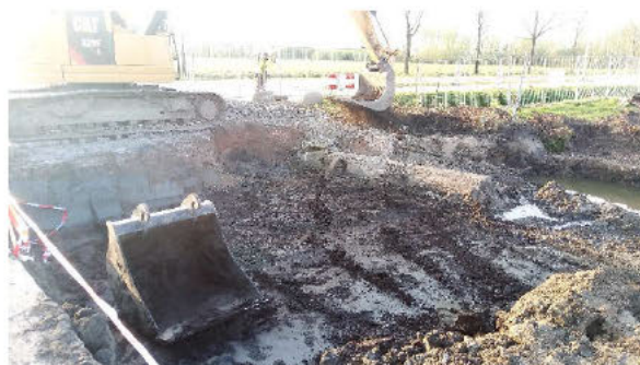
Foto 6: Situatieoverzicht sanering bij inrit (bodem 51 t/m 54). Tweede extra tank grotendeels vrijgegraven. Eerste extra tank reeds gesaneerd.
