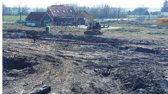
Foto 6: Locatie van inpandig onderzoek; gezien vanaf westelijke richting.
