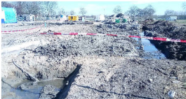
Foto 13: Sitatieoverzicht in pandige deel na verwijdering van alle verhardingen. Schone bovengrond boven bodem 13 is eraast in depot gezet. Aangrenzend te saneren voormalige wasstraat (boden 11 en 12). Tevens het aangetroffen extra in pandige tankje linksonder zichtbaar (leidingwerk + mangat)
