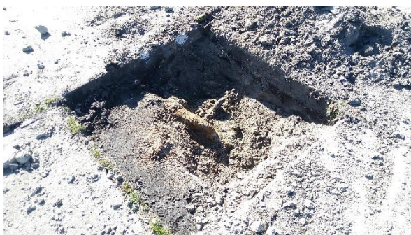
Foto 1: Mangat westelijke tank. Grond rond mangat is bemonsterd en blijkt verontreinigd
