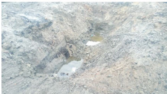
Foto 19: Eindsituatie sanering bodem rond aangetroffen 2 extra kleine tankjes voorterrein (bodem 71)
