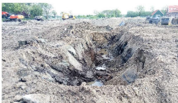
Foto 18: Eindsituatie sanering OBAS (bodem 62) en tank achter wasstraat (bodem 61).
