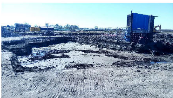
Foto 5: Eindresultaat sanering verontreiniging voor voormalige werkplaats/loods (bodem 21/22)
