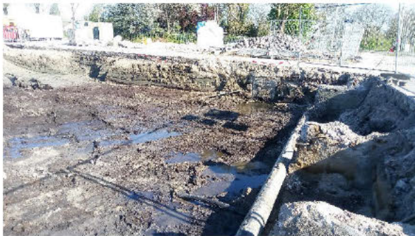
Foto 7: Eindsituatie sanering bij inrit met zicht op de noordelijke wand 54 en aan de rechterzijde wand 53 tegen het fietspad aan.
