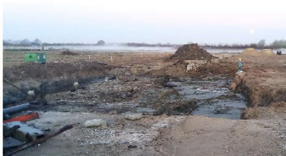
Foto 14: Overzicht na uitgevoerde saneringswerkzaamheden ter plaatse van bodem 11 t/m 13 en 41 en 42.
