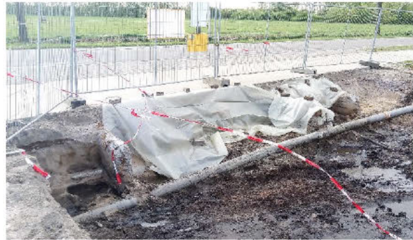
Foto 10: Tijdens sanering tijdelijk folie aangebracht ter afscherming van restverontreiniging wand 53. In de wand bevinden zich betonnen funderingsresten.
