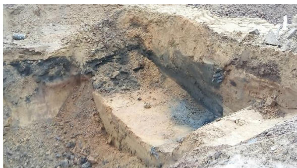
Foto 3: Tijdens de ontgraving is de oude afdekking met folie zintuiglijk goed waarneembaar.
