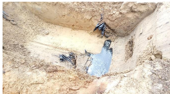
Foto 2: Het folie dat de restverontreiniging scheidde van de omliggende grond wordt aangetroffen en het grondwater is bereikt.
