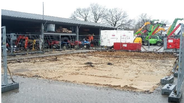
Foto 1: Startsituatie bodemsanering. Verharding op saneringslocatie verwijderd. Bemaling van bouwput is aangebracht en loopt.
