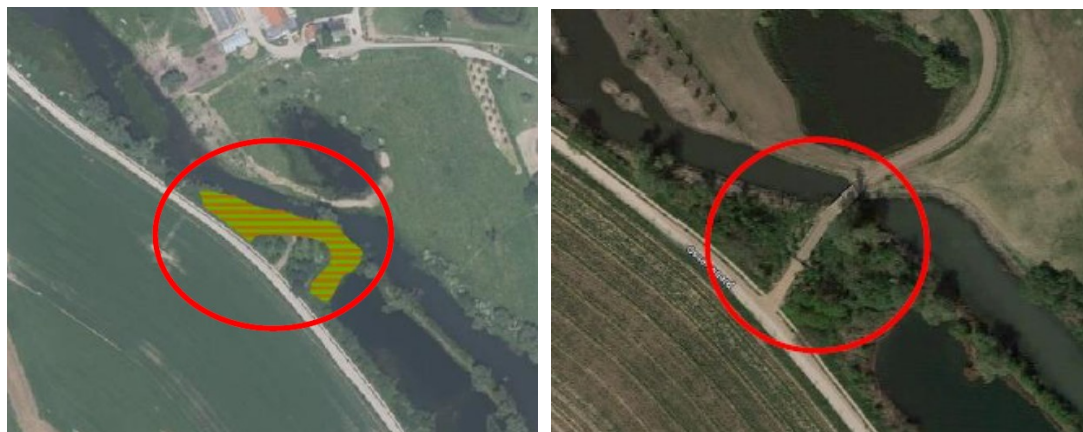
Figuur 2 De ligging van het zachthoutoibos (l) en de gerealiseerde toegangsweg en brug (r).
