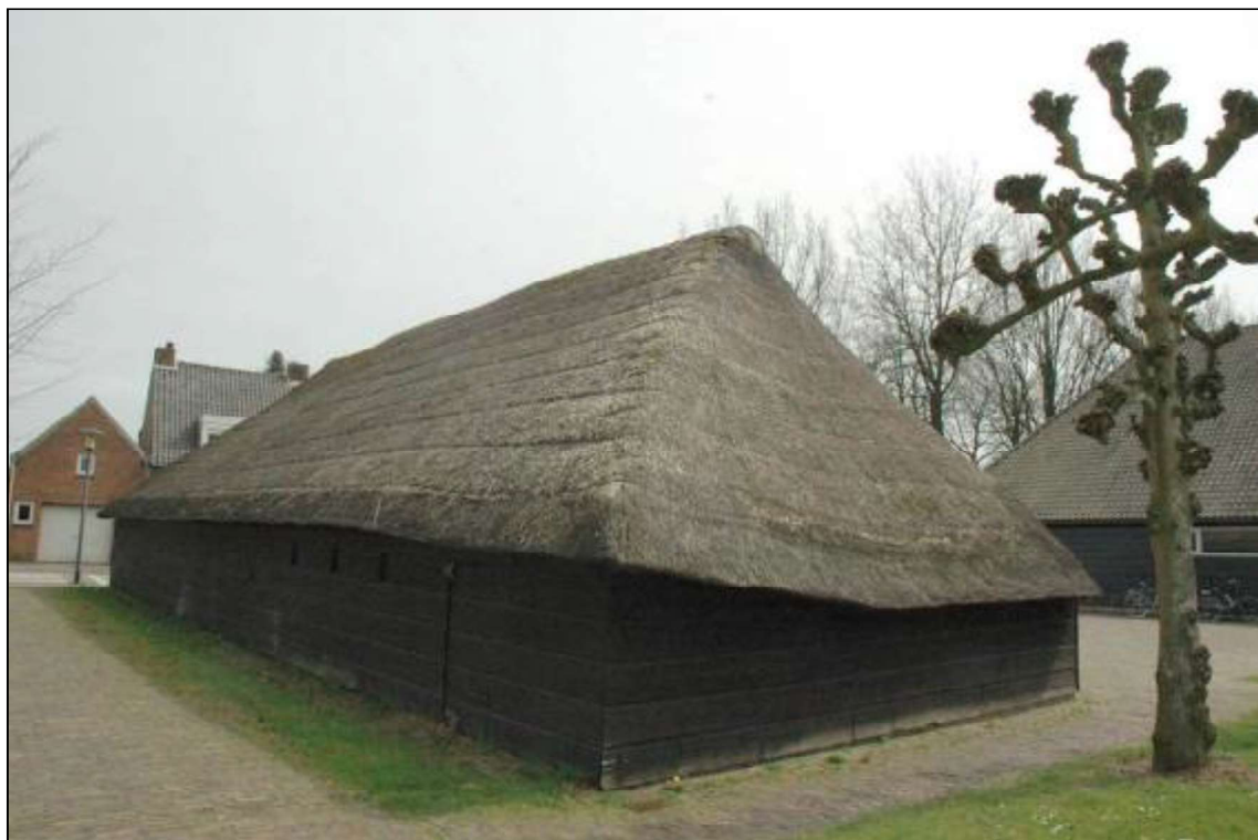
Afb. 3: De voorgevel aan de zuidkant.
