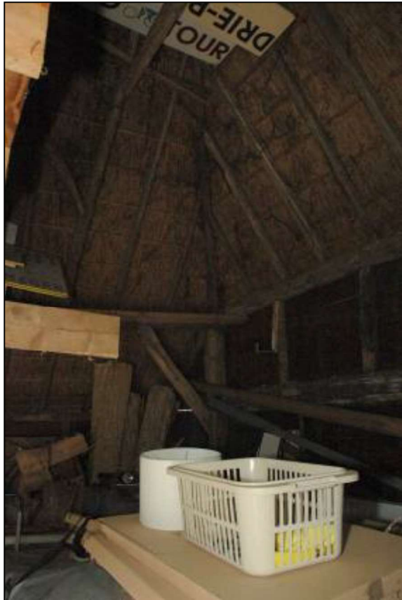
Afb. 7: De afgesloten ruimte aan de rechterkant van de karkooi met de draagconstructie, gezien naar achter.
