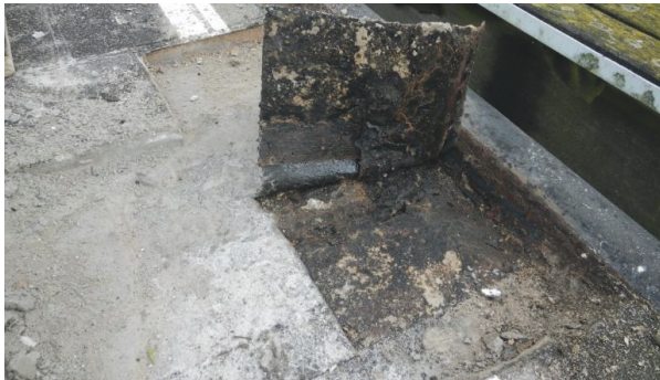
Figuur 7 Bestaande dek afwerking sluiskeiders
