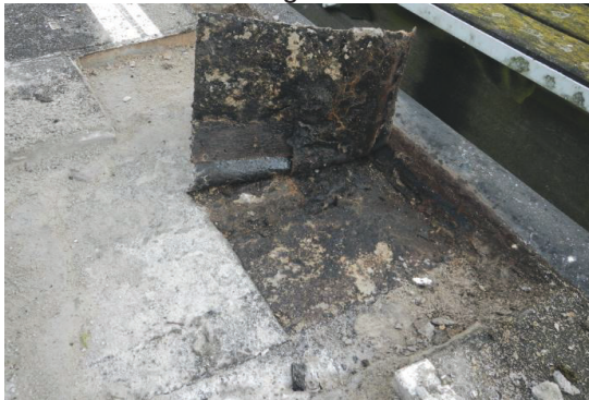
Figuur 11 Bestaande dek afwerking sluiskeiders
