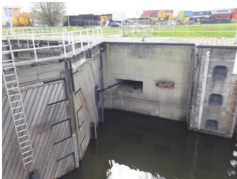
Figuur 4 Bestaande vloeddeuren buitenhoofd sluis
