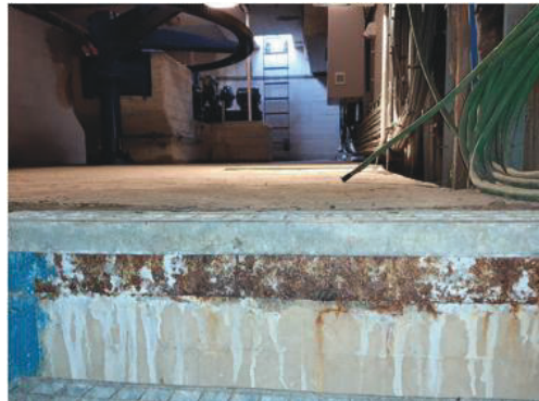
Figuur 12 Roest op stalen rand trap naar ebdeur
