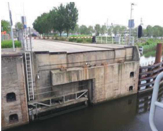
Figuur 8 Situatie ebdeuren binnenhoofd sluis
