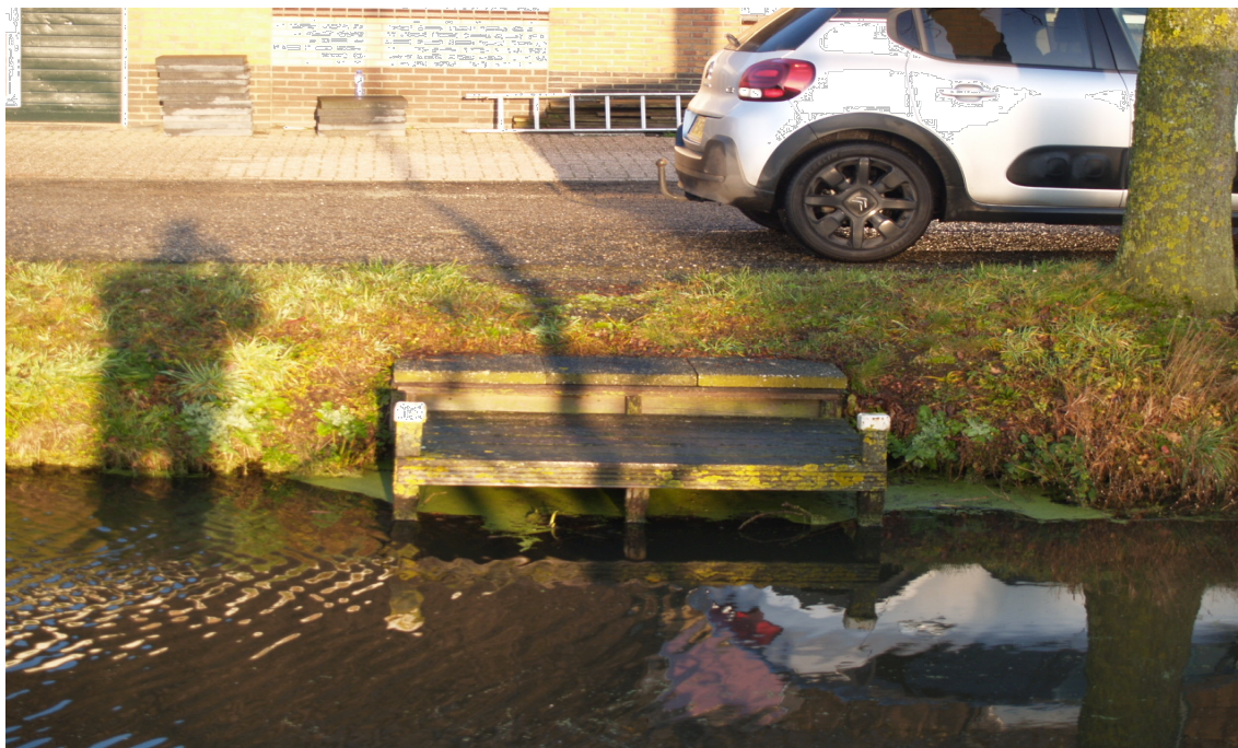
Foto te herplaatsen steiger
