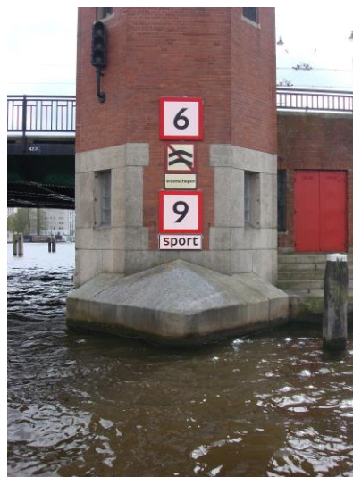
Foto 6: voet kelderpijler (brugwachtershuisje)
