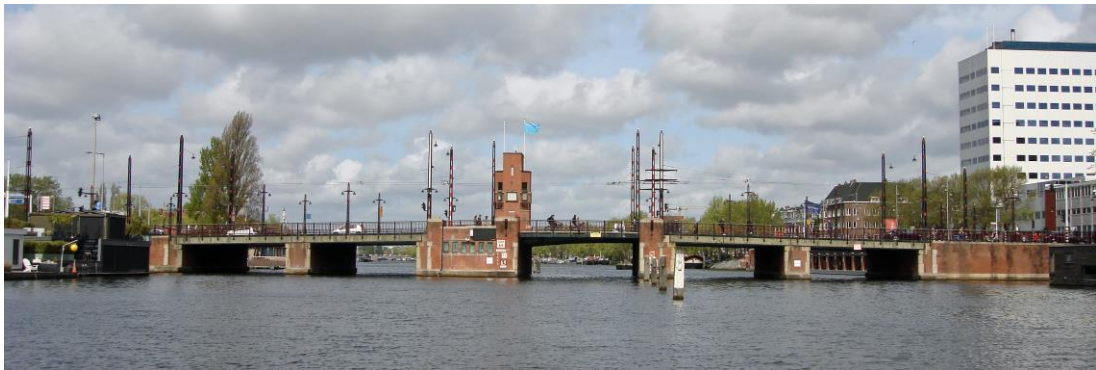
Foto 1: aanzicht Berlagebrug zuidzijde
