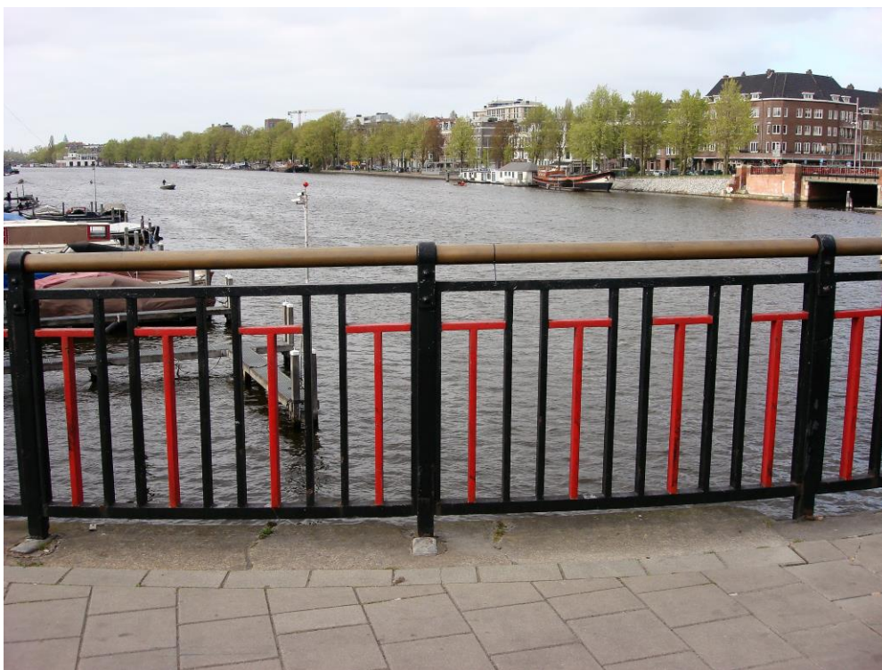
Foto 14: aansluiting leuning aan natuursteen banden.
