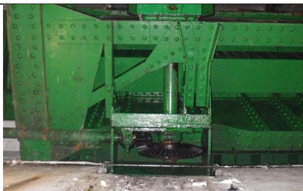
Overzichtsfoto 3: Kroonwieloverbrenging voorkant ballastkist links
