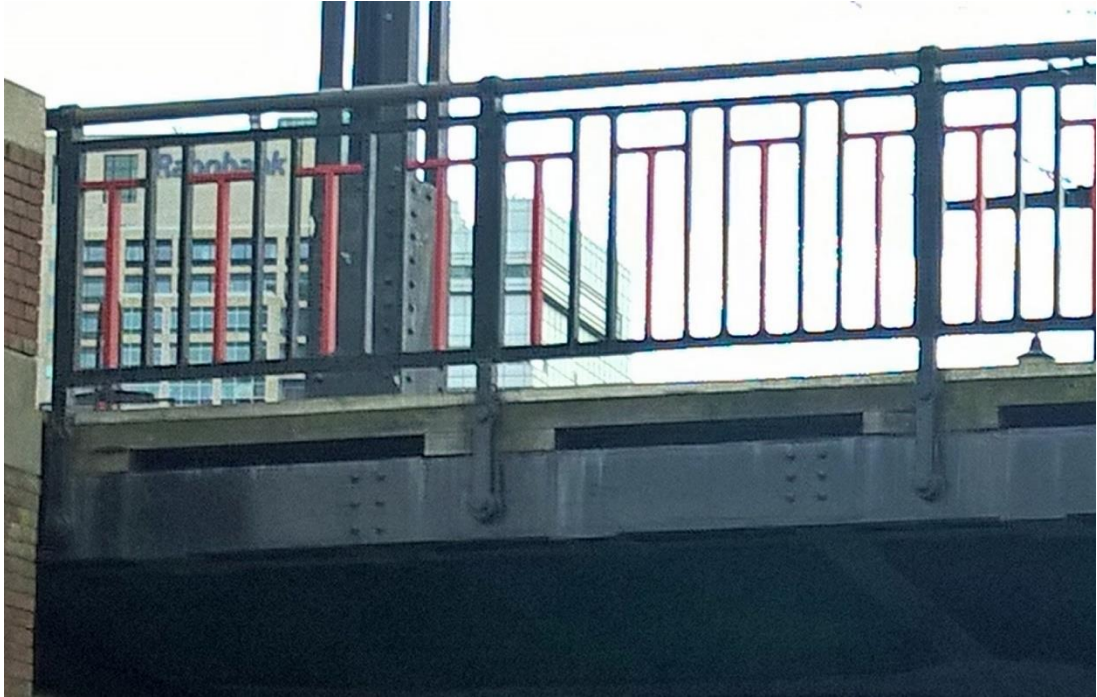
Foto 20: randligger val met houten trottoirconstructie.
