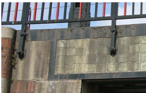
Foto 15: bevestiging leuning aan brugdek.
