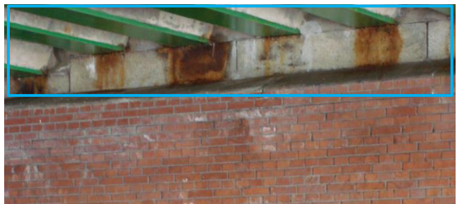
Foto 33: roestvorming oppervlak natuursteen
