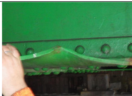
Detailfoto 11: Deformatie flens dwarsdrager
