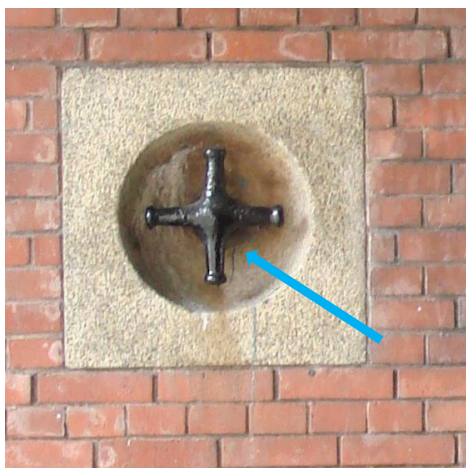
Foto 43. Haalkom met gietijzeren kruisvormig haalkomijzer. (aansluiting haalkomijzer aan het natuursteen sterk gecorrodeerd)
