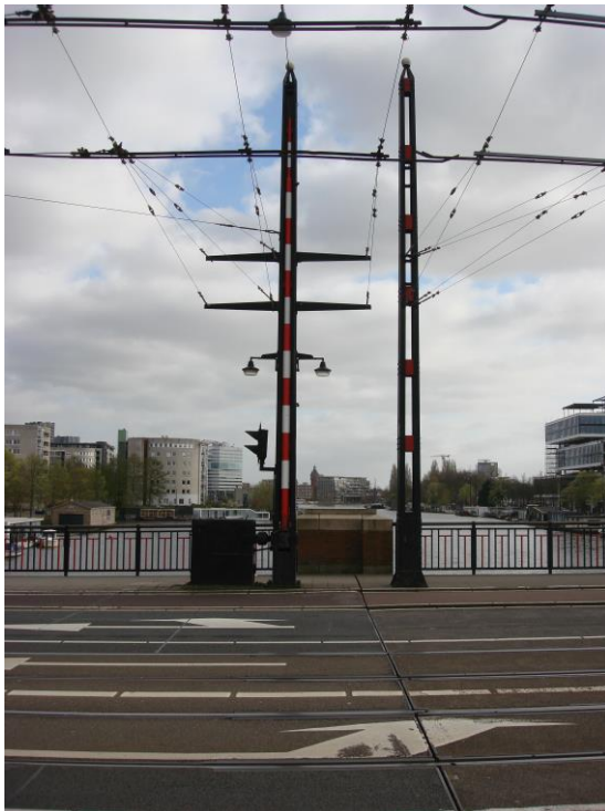
Foto 17: masten t.b.v. spankabels
