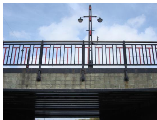
Foto 14 aansluiting leuning aan brugdek.
