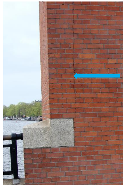
Foto 28: scheurvorming.
