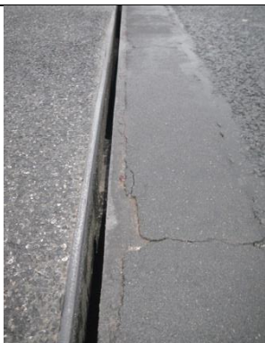
Detailfoto 19: Afname slijtlaag voegovergang voorhar
