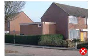
zijaanbouw te hoog
