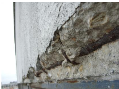
voorbeelden randen met onvoldoende dekking
