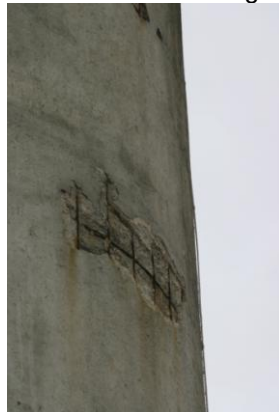
voorbeelden randen met onvoldoende dekking
