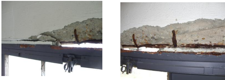
foto 24: bevestiging kozijn in mortelbed
