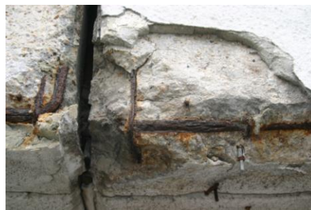
voorbeelden randen met onvoldoende dekking
