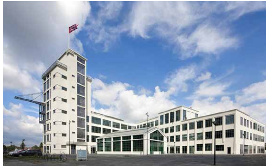
... na de restauratie
