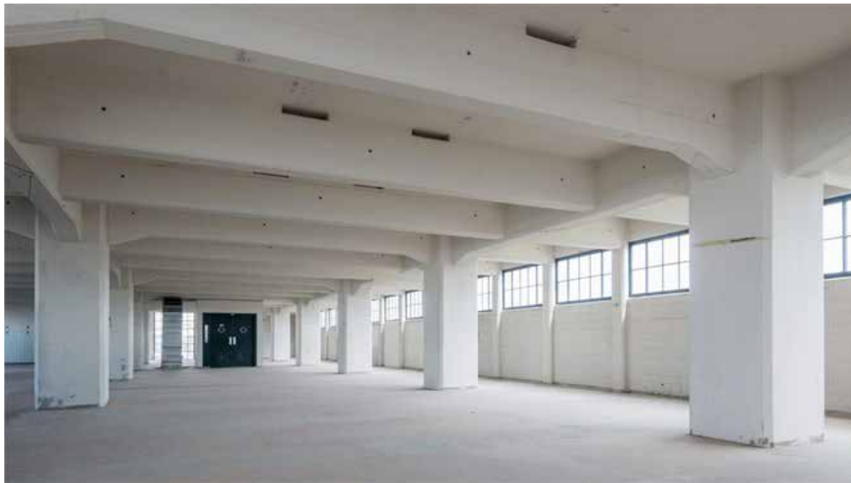
interieur fabriek, huidige situatie
