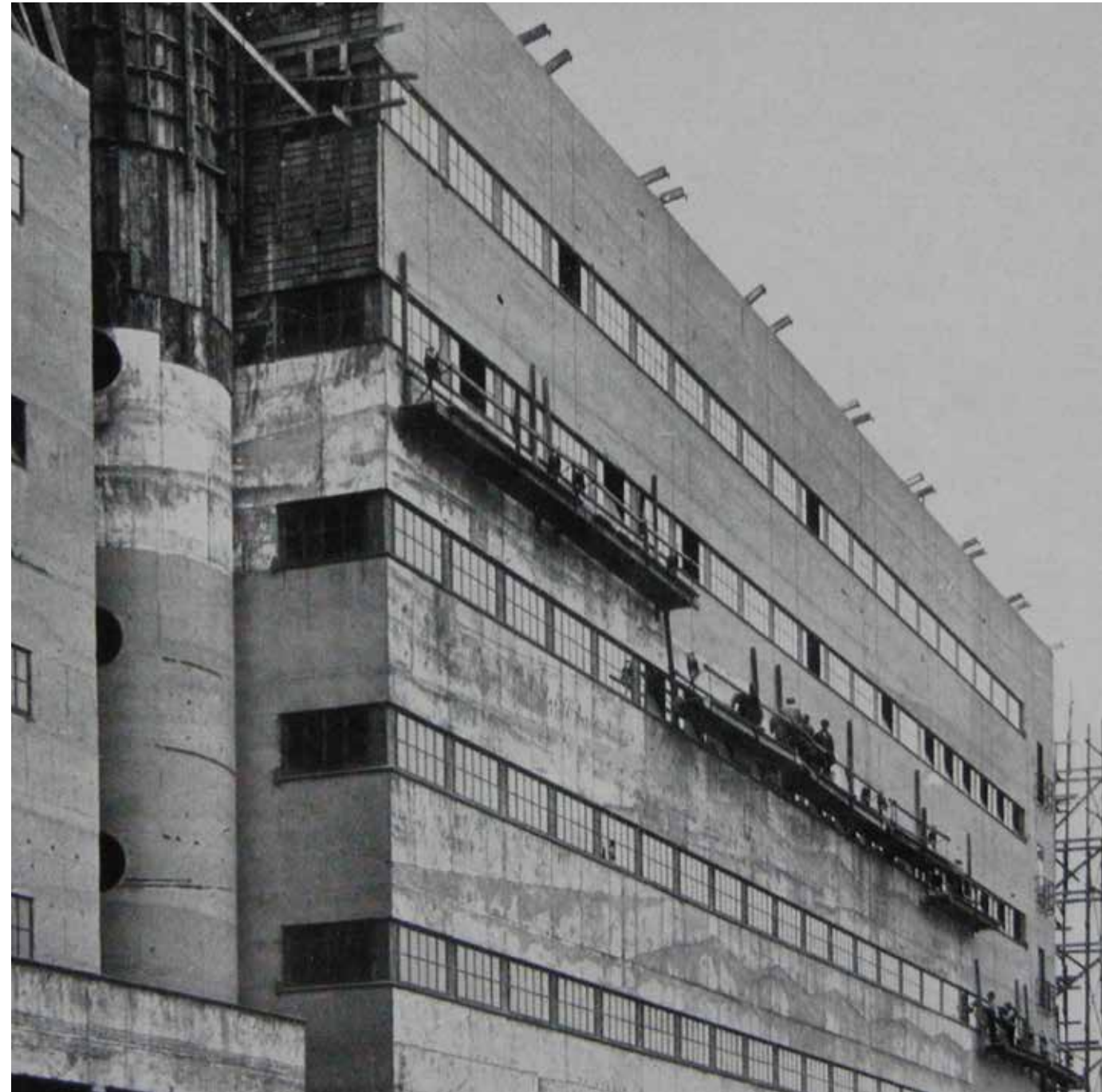
bouchaderen van het beton
