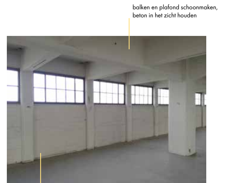
wanden schoonmaken, beton in het zicht houden
