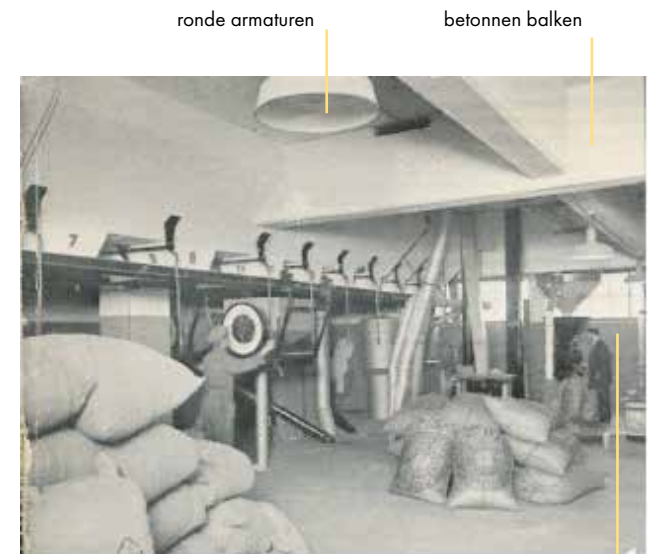
betonnen wanden, soms afgewerkt met tegels (afhankelijk van de functie vd ruimte)
