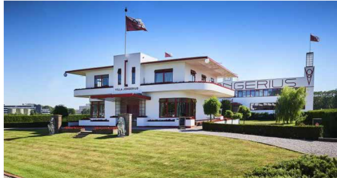
... na de restauratie
