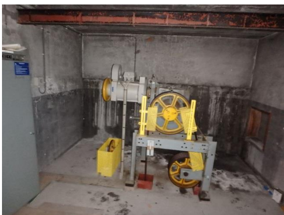
Foto 5: liftmachinekamer twee remvoeringen asbestvrij op 6 e verdieping
