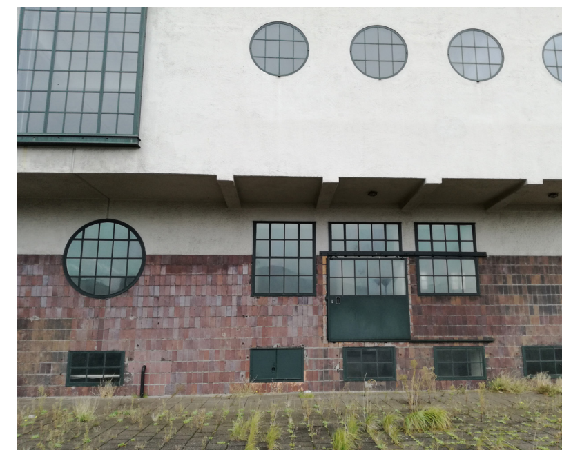
gevel 3 - diverse kozijnen
