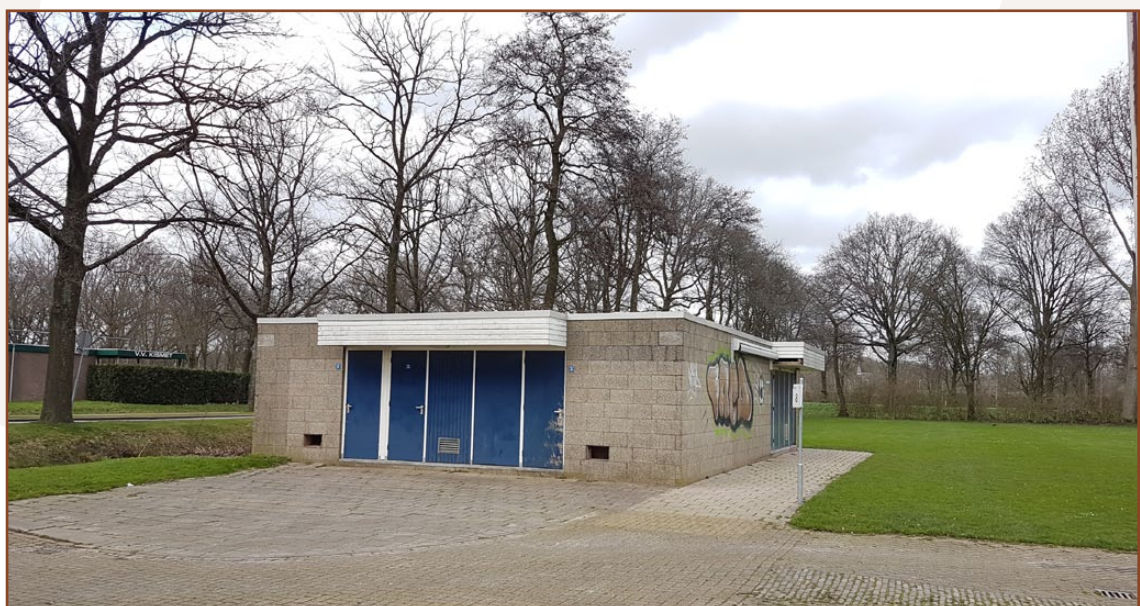
Afbeelding 3: Het te slopen kleedkamergebouw met links de toegangsweg tot Sportpark Zuilen vanaf de Burgemeester Norbruislaan en rechts een deel van het sportveld.
