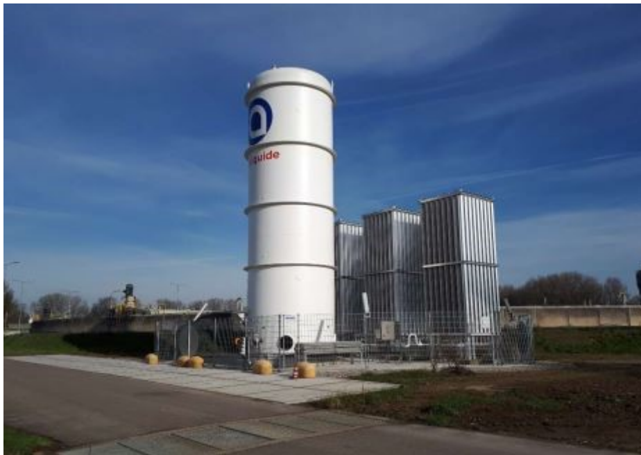
No 15: Zuurstofopslagtank
