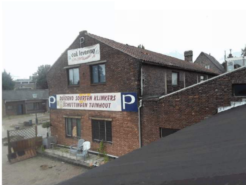
Westeinde 132d, bedrijfsgebouw achterzijde
