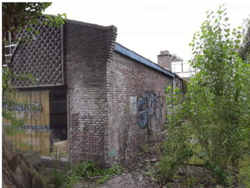
Westeinde 132d, bedrijfsgebouw achterzijde
