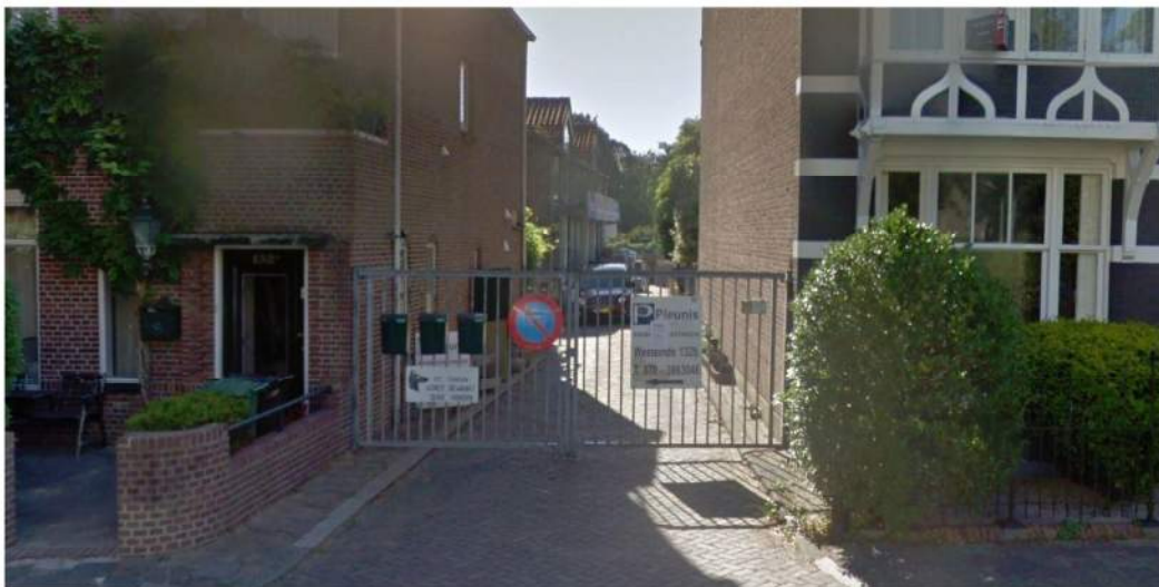
Huidige situatie plangebied entree (bron: google Street View)
